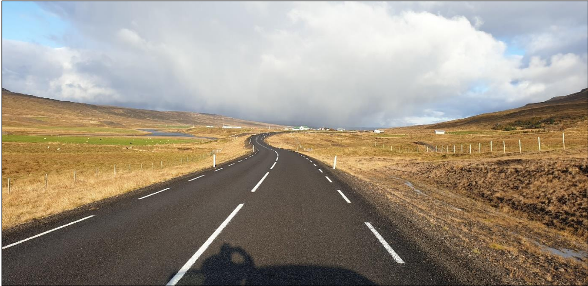
Mynd 5.1 Ljósmynd af Laxárdalsvegi þar sem hann hefur verið endurbyggður.
